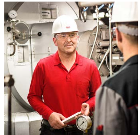
Höhere Effizienz – entlang der gesamten Wertschöpfungskette: Betriebsmeister Peter Jessen (links) und sein Kollege Andy Jarosch arbeiten an der Optimierung des Kraftwerks am Henkel-Stammsitz in Düsseldorf. Bereits in den frühen 1980er Jahren hat Henkel hier begonnen, Emissionen gezielt zu reduzieren und den Wirkungsgrad des Kraftwerks zu verbessern.
